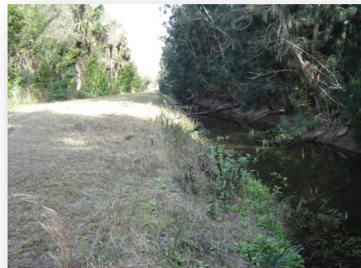
Existing M-1 Canal
